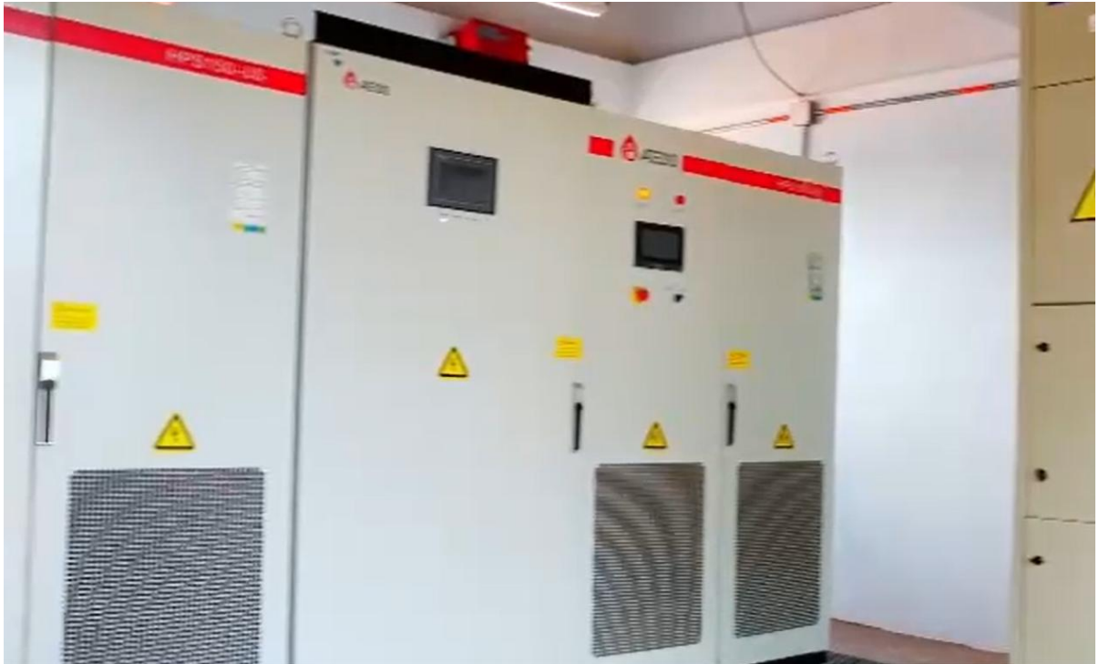
Dos inversores híbridos de 150kW de ATESS
